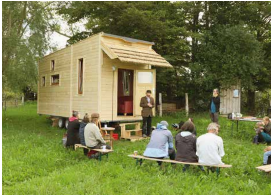
Ein Tiny House aus Moorpflanzen, Reet auf dem Vordach, Rohrkolben zur Dämmung, Erle auf dem Boden
