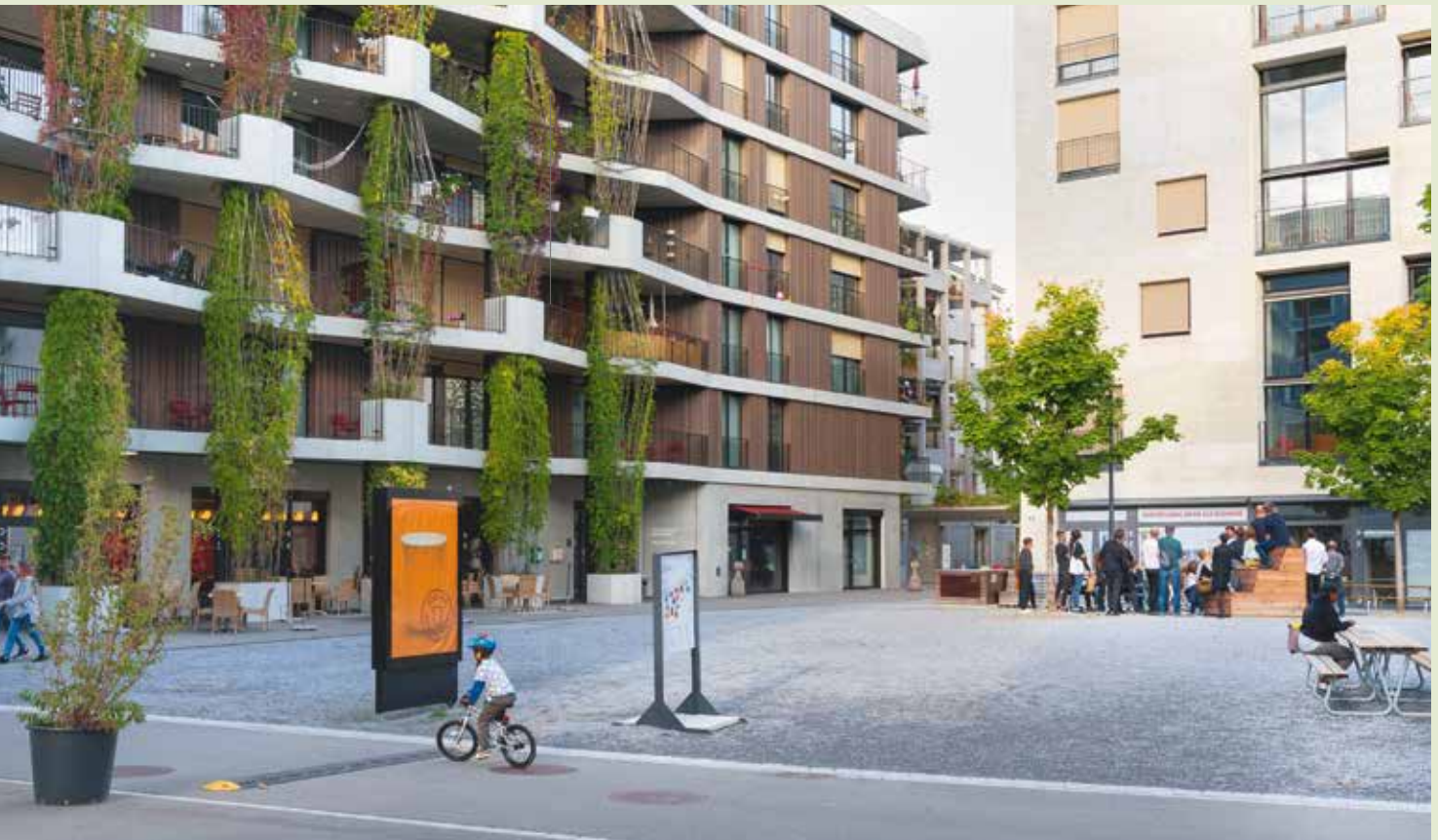
In Zürich wurde auf dem Gelände einer ehemaligen Betonfabrik ein ganzes Quartier errichtet: Das Hunziker-Areal besteht aus 13 energieeffizienten Häusern – Wohnraum für 1300 Menschen
