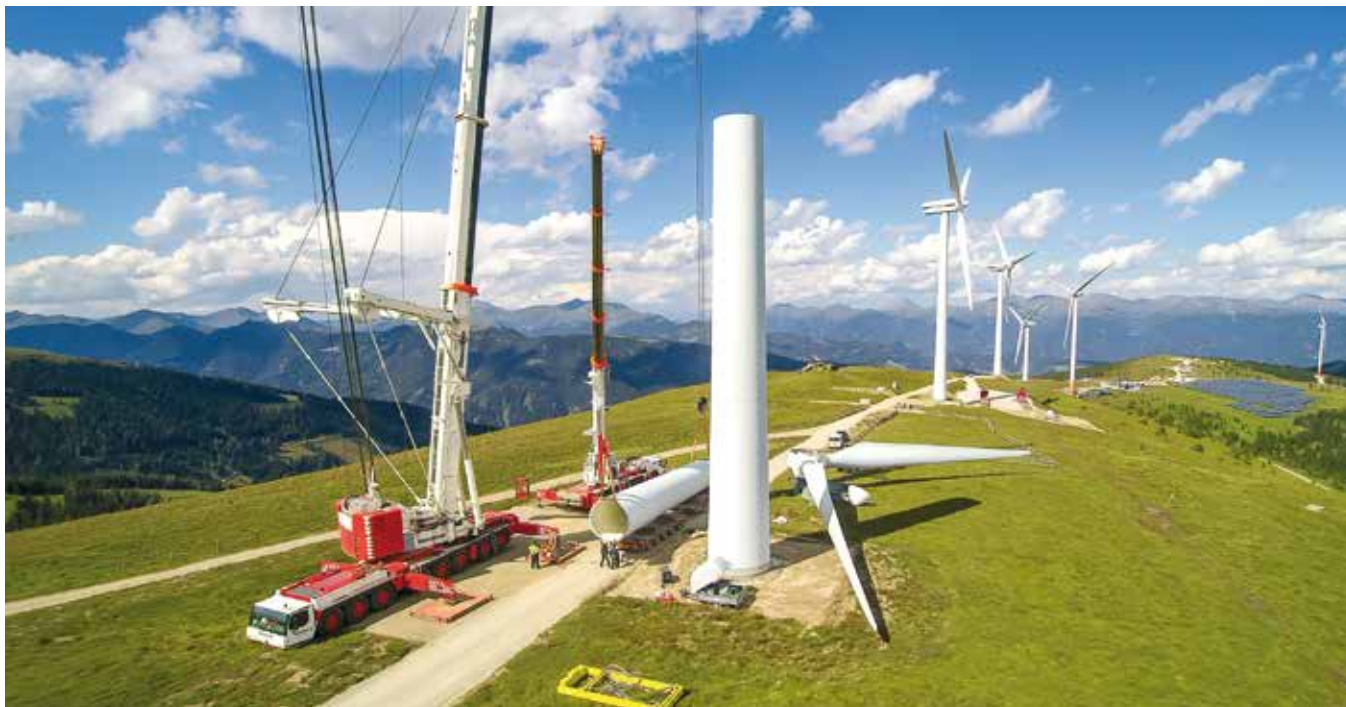
Bau von Windrädern, hier in der Steiermark – ein immer seltenerer Anblick: In Deutschland wie auch in Österreich stagniert der Ausbau der Windkraft
